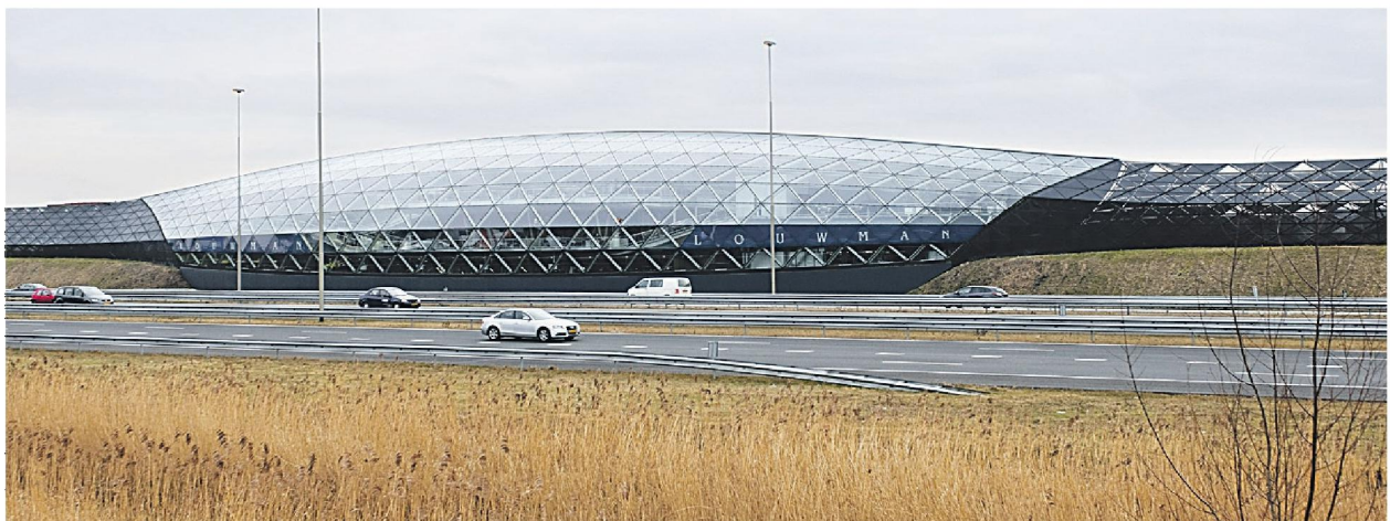
Het geluidsscherm aan de A2, tevens onderdeel van de showroom van voormalige autohandelaar Hessing.
