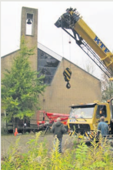
De kerkklok wordt uit de toren van de Ichthuskerk in Harlingen getakeld.
