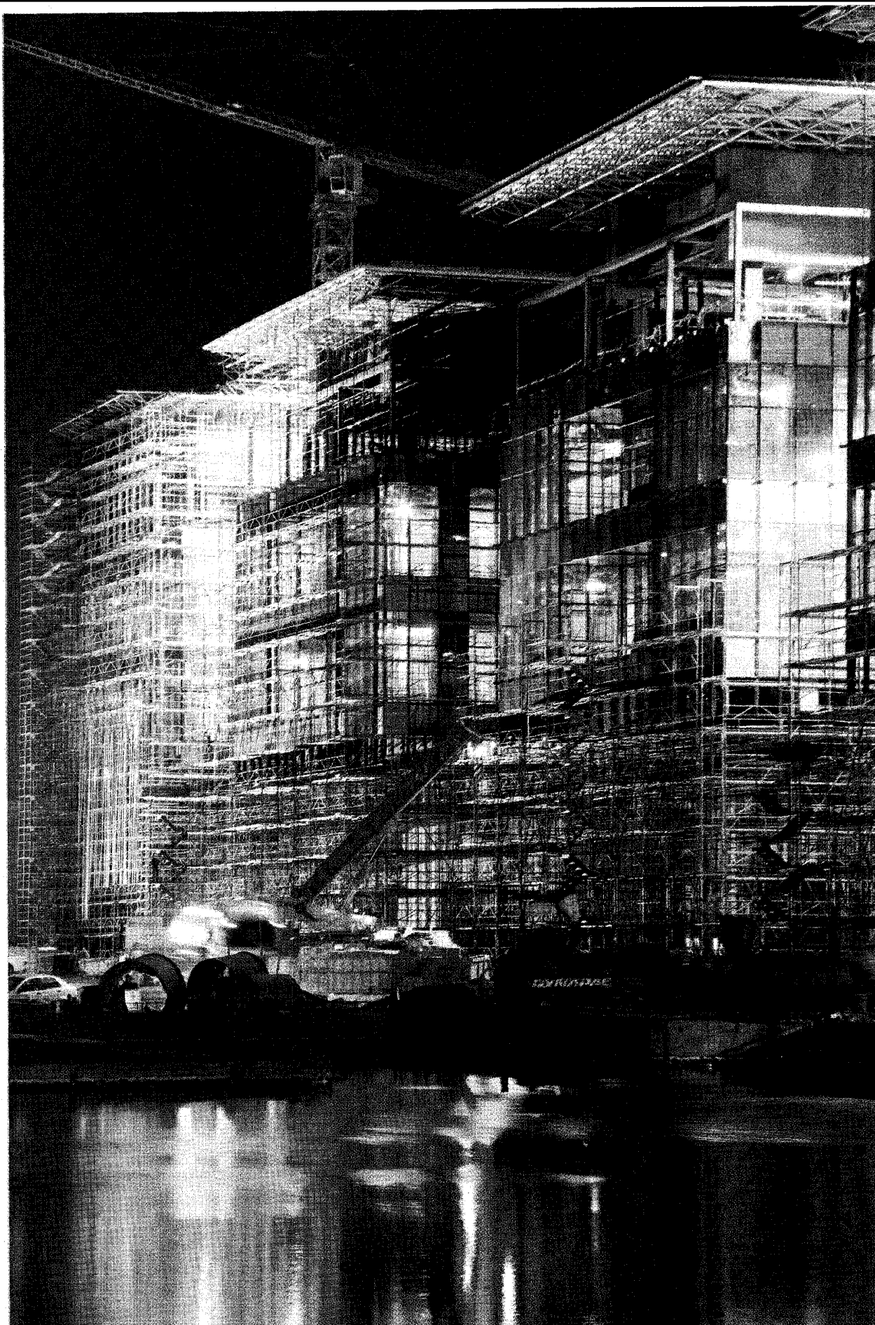
Onderzoekslaboratorium in aanbouw van de Koning Abdullah Universiteit in Thuwal, 80 kilometer ten noorden van de stad Jeddah. Foto AFP
